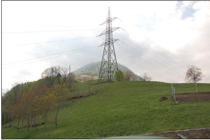
Figura 59 - Traliccio alta tensione
