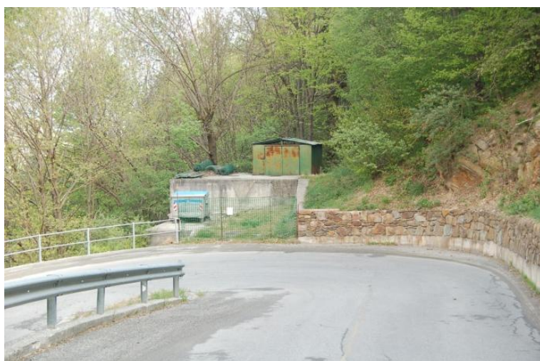
Figura 36 - Il depuratore di Bema
